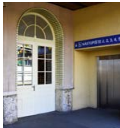
V rámci rekonštrukcie opravili aj historické dvere s oblúkovým nadsvetlíkom, ktorými vojdete dnu aj priamo z nástupišťa.
