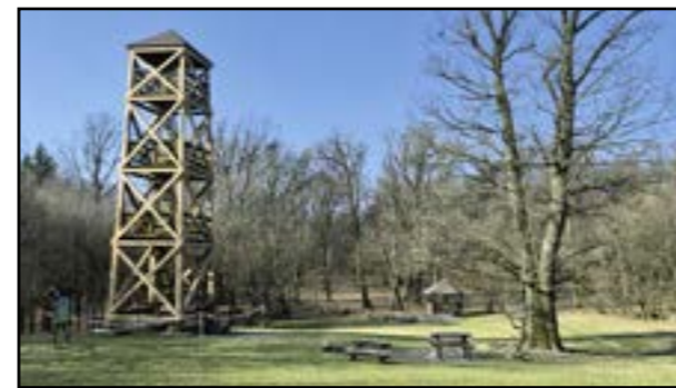
Rozhľadňu obnovovali v marci, kedy stabilnejšie počasie umožnilo náterom optimálne vyschnúť a dozrieť.
