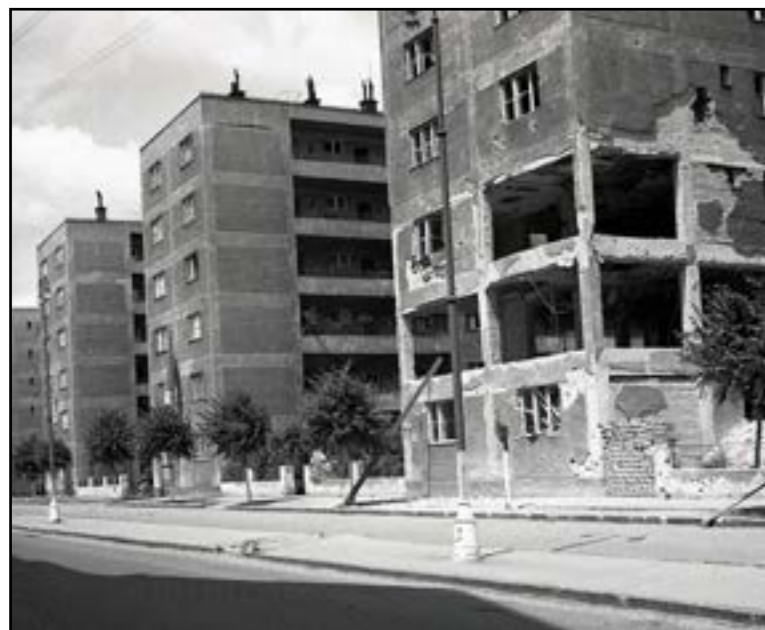
1945: Pohľad na časť súboru Unitas na Šancovej ulici krátko po skončení vojny
