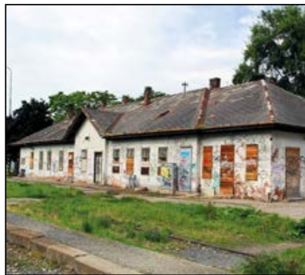
Pôvodná budova stanice na Trnavskom mýte chátra.
