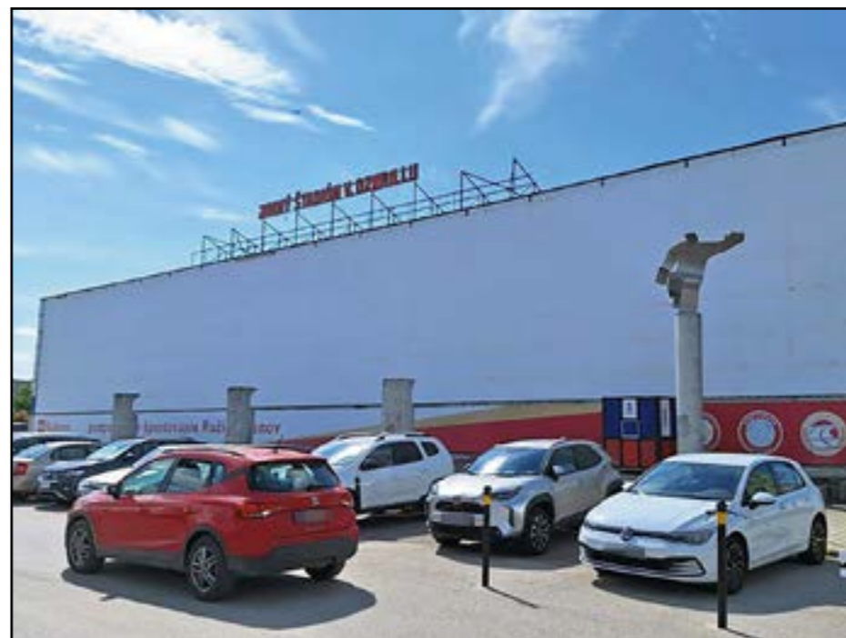
Štadión V. Dzurilla vznikol podľa projektu architekta Tibora Gebauera, ktorý je tiež autorom tréningovej haly Zimného štadióna O. Nepelu.
