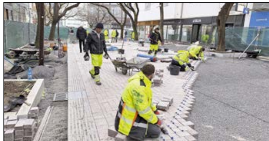
Na Poštovej ulici koncom minulého mesiaca kladli novú dlažbu.
