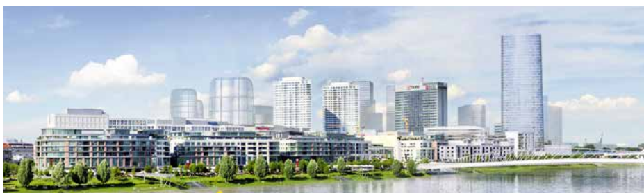
Pohľad na budúce nové centrum mesta zo Starého mosta.
