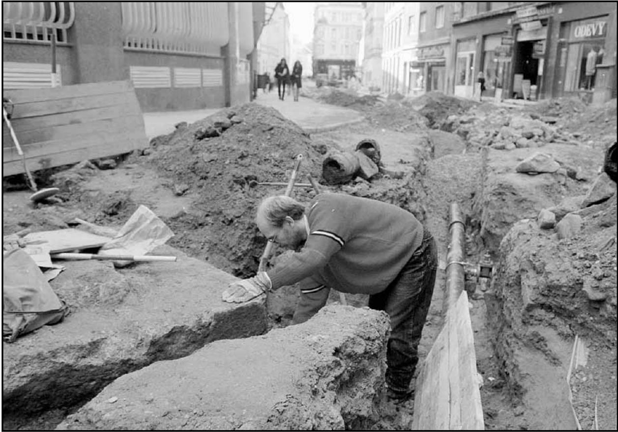
Pri obnove povrchu Laurinskej ulice boli pod zemou objavené aj zvyšky systému opevnenia Laurinskej brány s mostom cez vodnú priekopu. Po ukončení archeologického prieskumu a vydláždení bude tento nález pripomínať informačná tabuľa a odlišný povrch dlažby.
