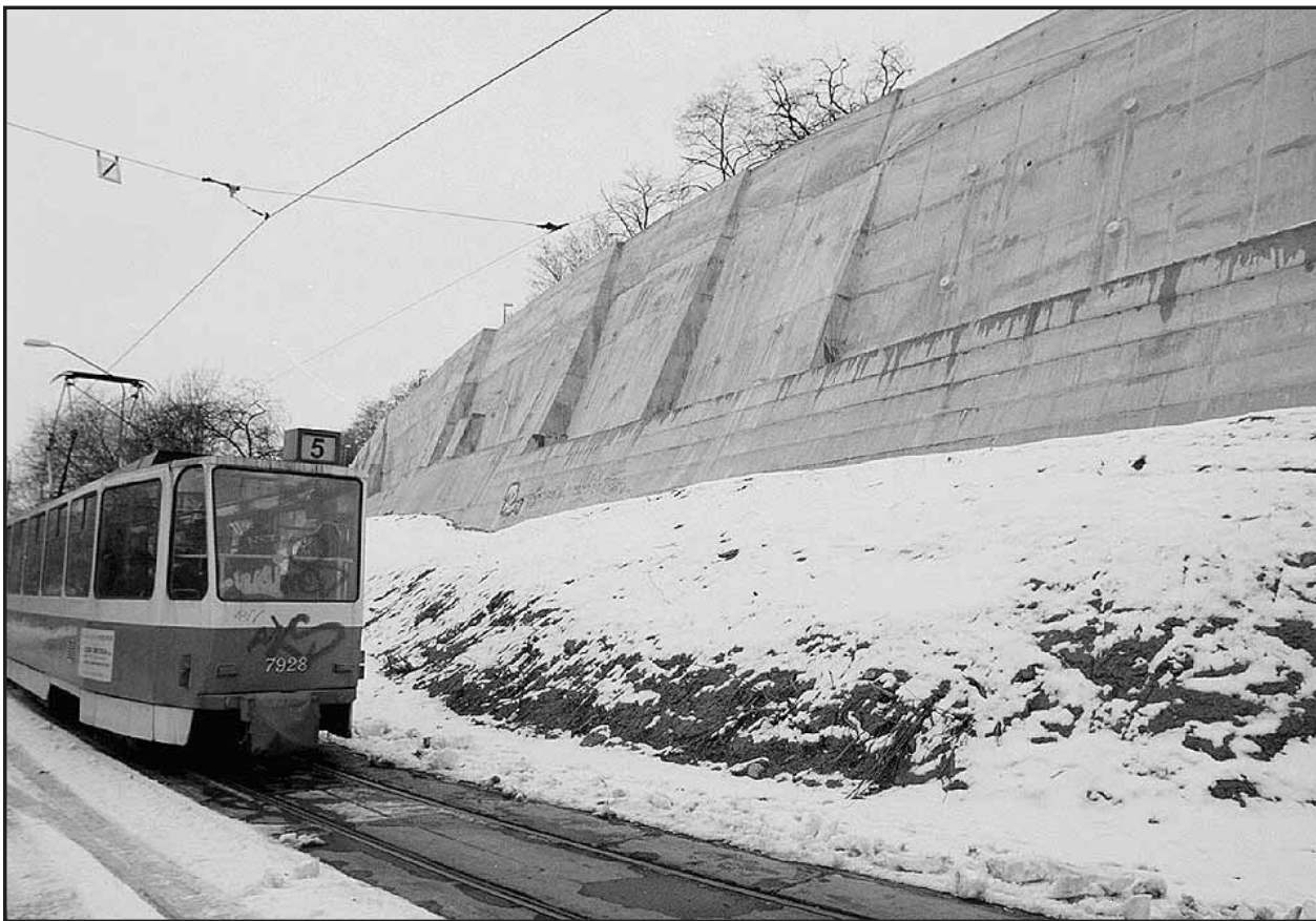
Po takýchto úpravách už žiadny zosuv pôdy na električkovú trať pri tuneli nehrozí.
