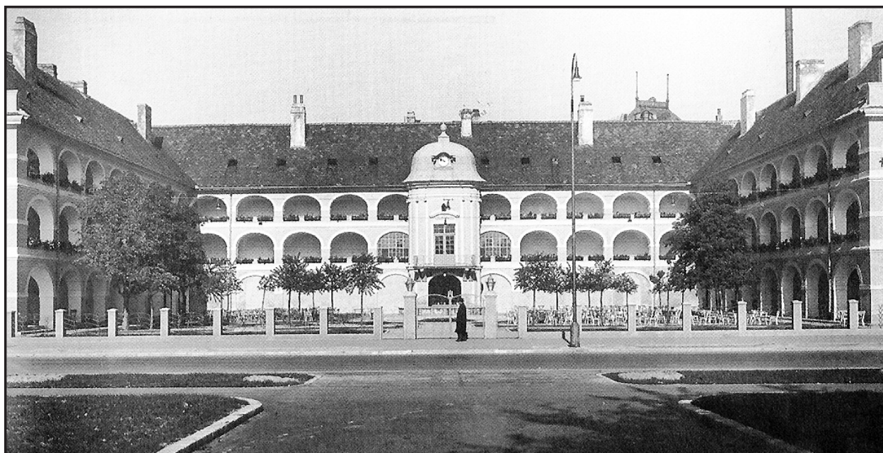
A takto si pamätá Vodné kasárne väčšina Bratislavčanov - ako trojkrídlový objekt bez plechového premostenia.
