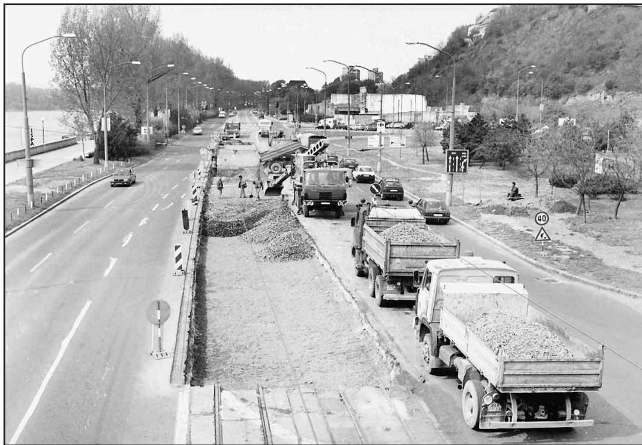
Oprava električkovej trate na nábreží potrvá do konca júna.
