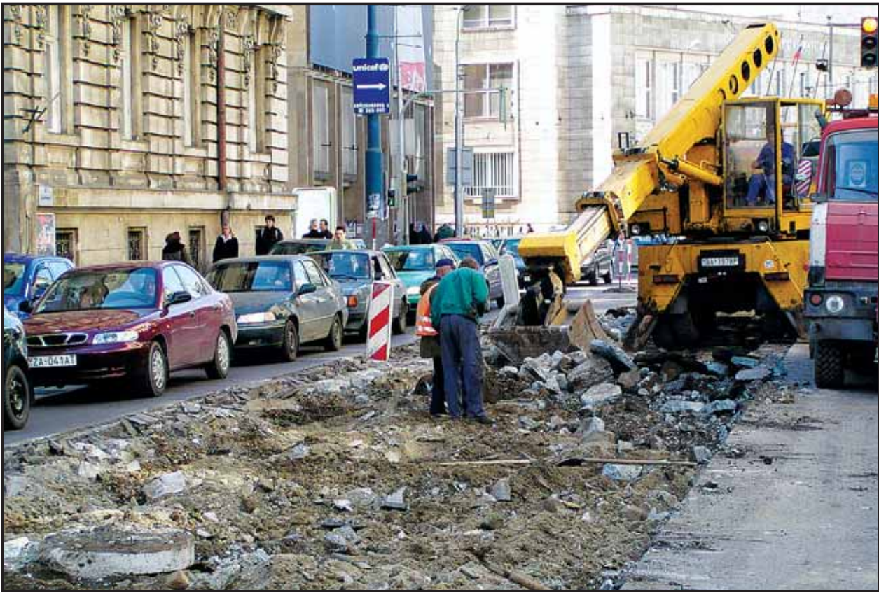
Rozkopaná Štúrova ulica zaskočila nejedného Bratislavčana. Premávka tu podľa prísľubu Dopravného podniku bude obnovená začiatkom mája. FOTO - Slavo Polanský
