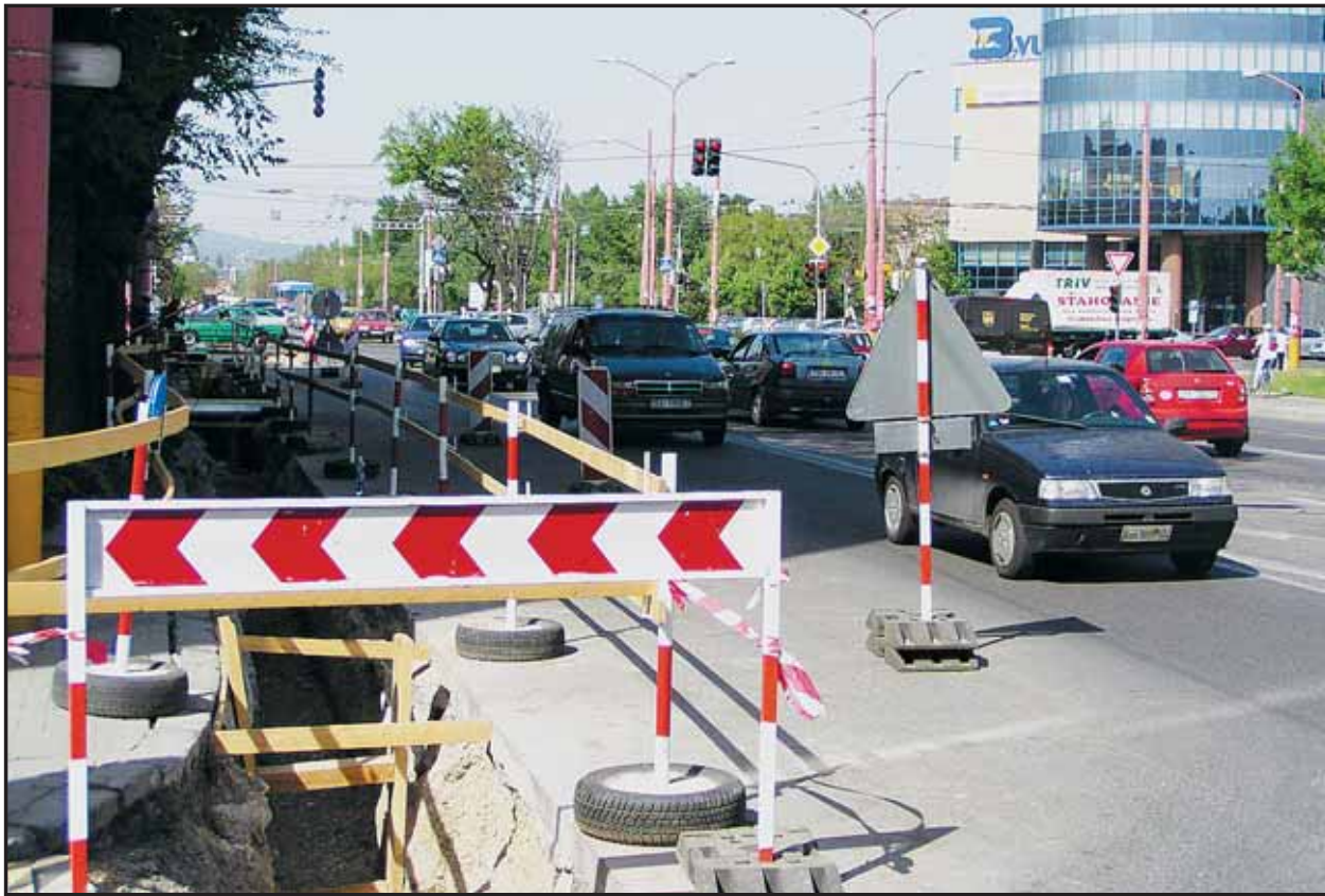
Až do 15. októbra bude trvať rekonštrukcia kanalizačnej siete na Dostojevského rade.
