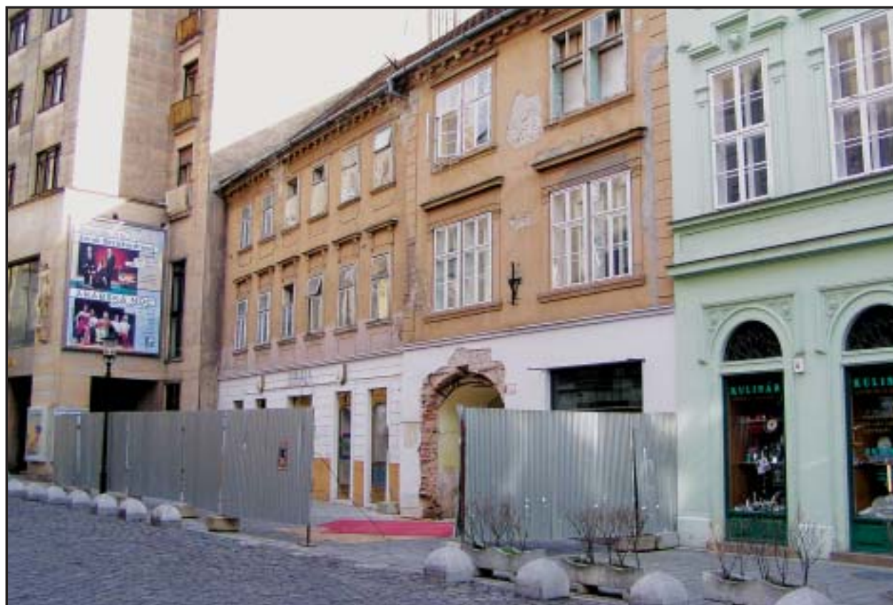
Stredoveký meštiansky dom na Laurinskej 18 opravia do júla 2005.
