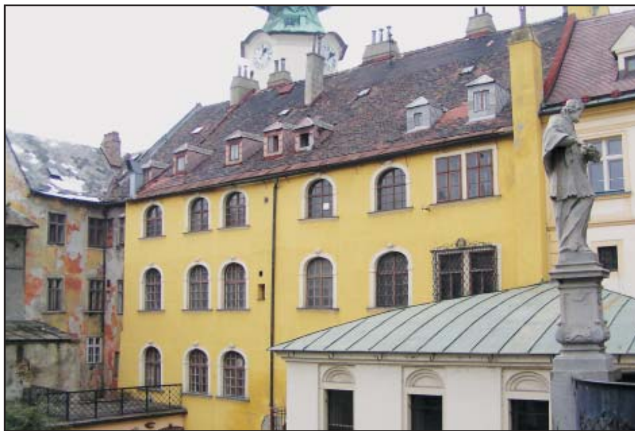
Po rekonštrukcii bude v domoch na Michalskej ulici 22 a 26 apartmánový hotel.
