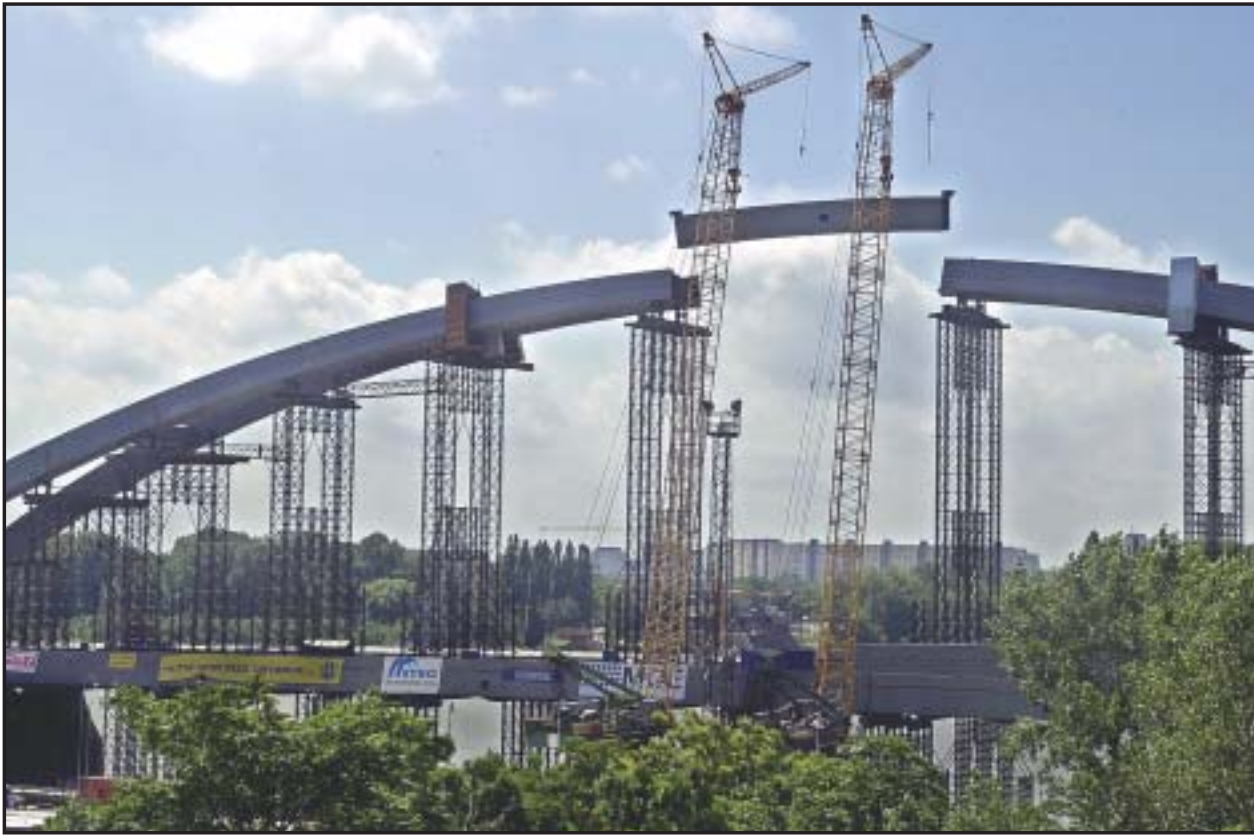
Obidva oblúky konštrukcie hlavného mostného poľa mosta Košická sú už dokončené.
