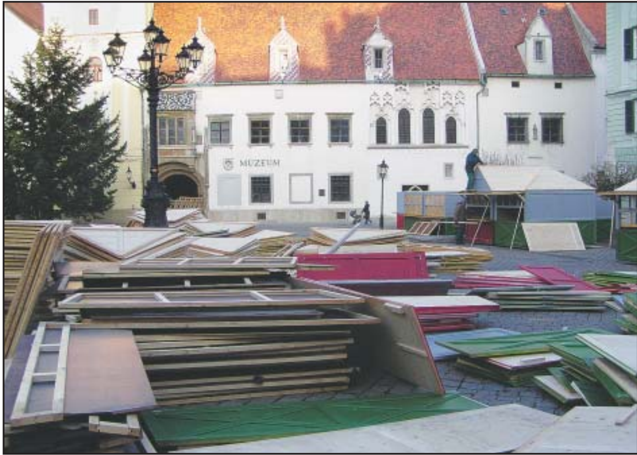
Prípravy na tradičné Vianočné trhy sú v plnom prúde - na Hlavnom námestí v uplynulých dňoch začali s montážou predajných stánkov, ktorých rozmiestnenie bude identické ako v minulom roku. Na námestí už stojí aj 13 metrov vysoký vianočný strom, ktorý 26. novembra zažne primátor Andrej Ďurkovský. FOTO - Oto Limpus
