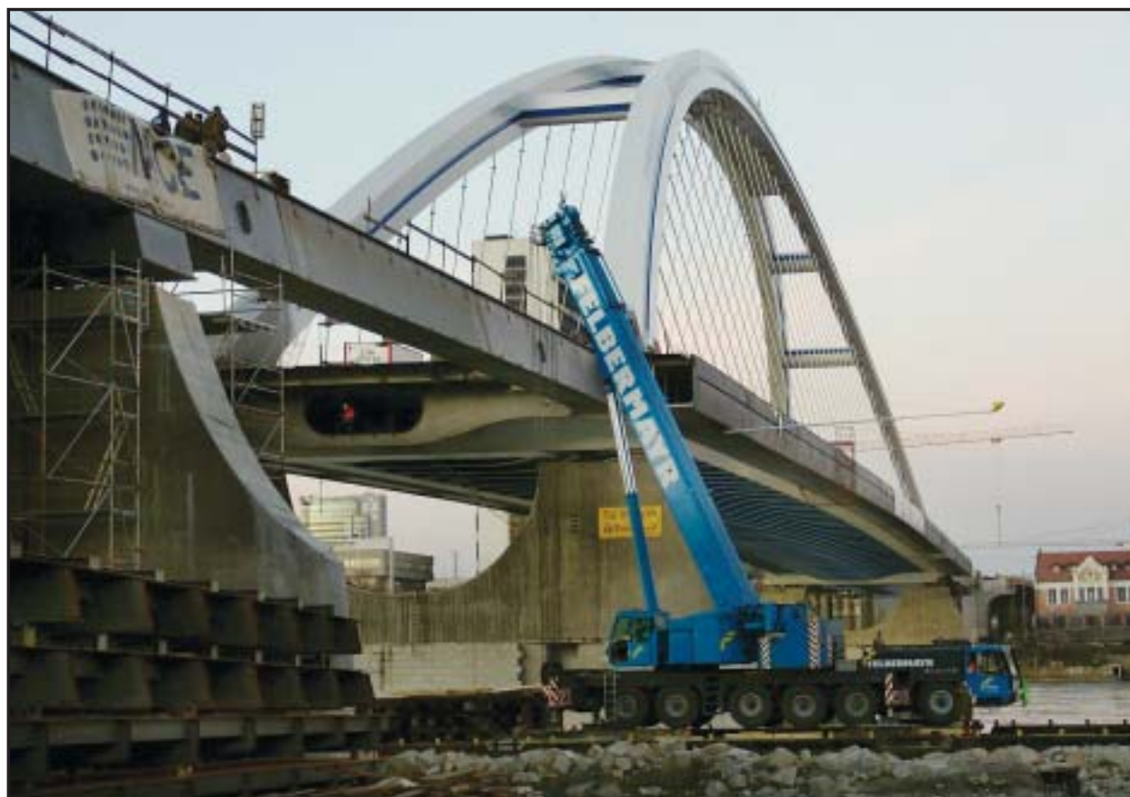
Po piatom moste sa od 25. novembra už dá prejsť z jedného brehu na druhý - v tento deň osadili medzi piliermi hlavné nosníky ocelevej konštrukcie, ktorá vyplnila poslednú chýbajúcu časť mosta. FOTO - TASR
