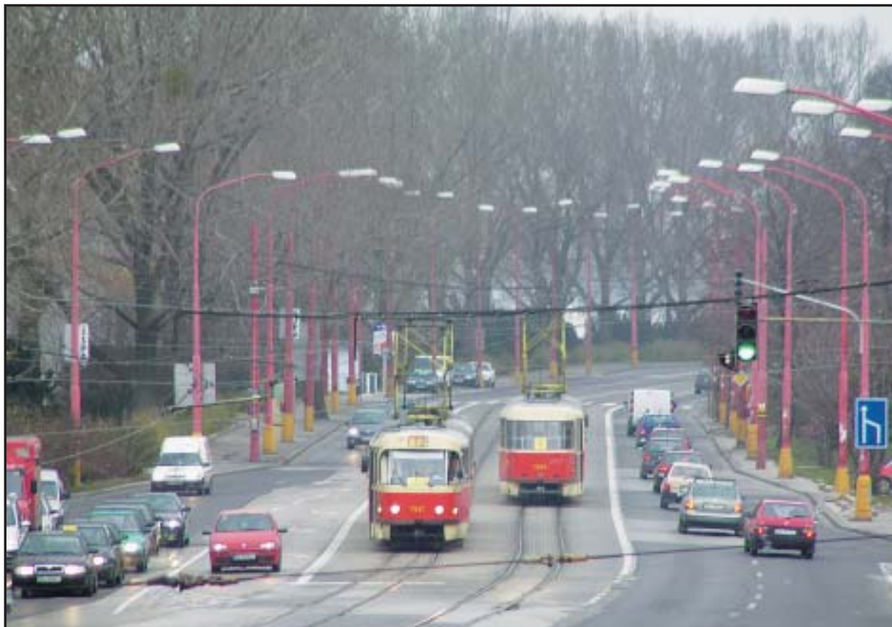
Od júna do augusta budúceho roku budú rozširovať cestu na Nábřeží arm. gen. L. Svobodu v smere od Karlovej Vsi do centra. Rozšírenie v opačnom smere sa bude realizovať v roku 2006. FOTO - Oto Limpus
