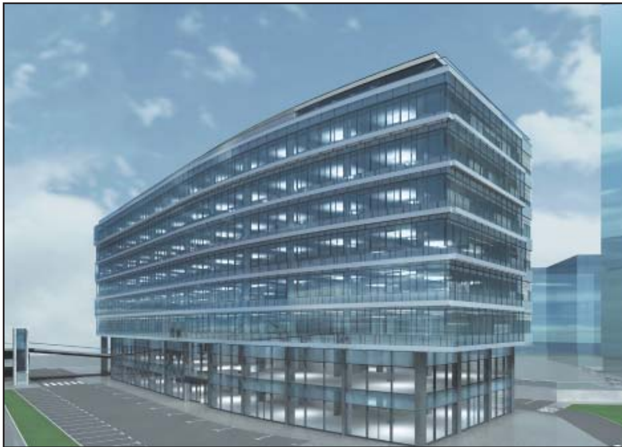
Oproti Auparku do roka vyrastie prvá budova kancelárskeho parku Digital Park.
