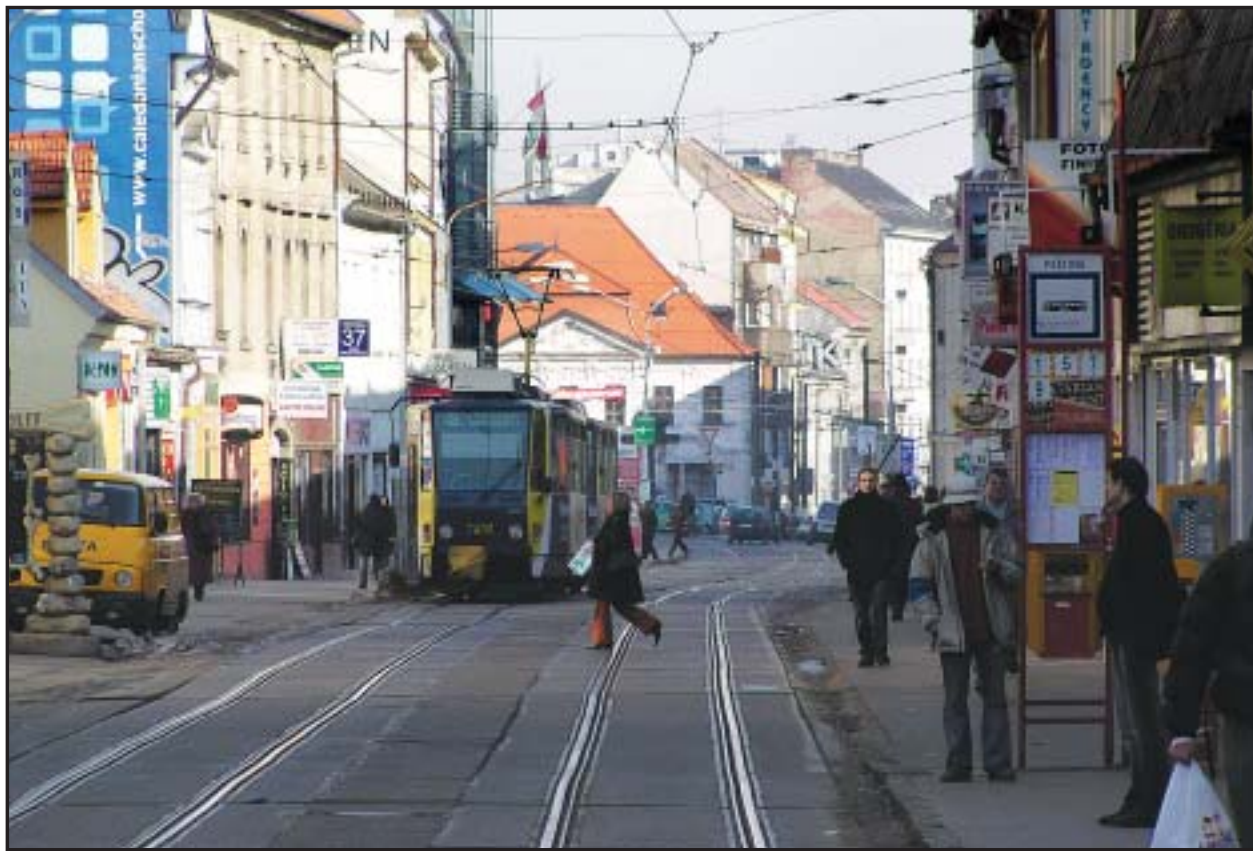
Na Obchodnej ulici sa ráta nielen s obnovou električkovej trate, ale aj s povrchovými úpravami a rozmiestnením prvkov drobnej architektúry. FOTO - Oto Limpus
