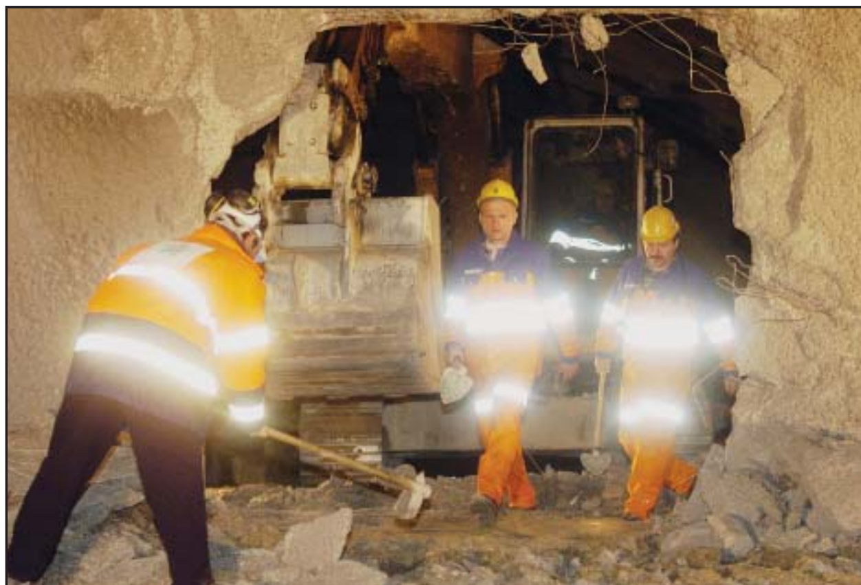
Vo štvrtok 10. marca prerazili prvú z dvoch rúr tunela Sítina, ktorý je súčasťou diaľnice D2.
