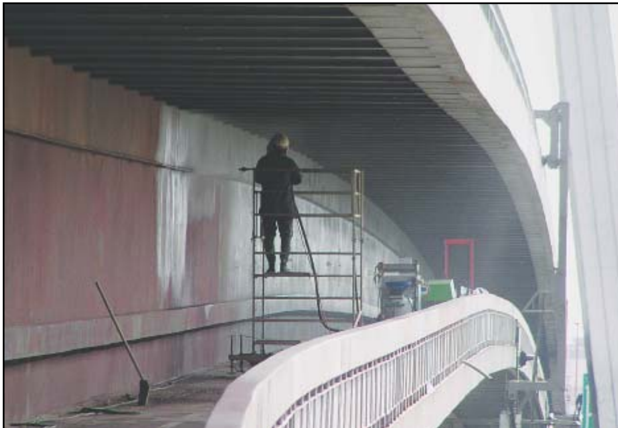
Vďaka špeciálnemu náteru, ktorý v týchto dňoch nanášajú na pešej lávke na Novom moste pracovníci firmy ARS, bude možné odstrániť nežiaduce výtvy sprejerov veľmi jednoduchým spôsobom. FOTO - Oto Limpus
