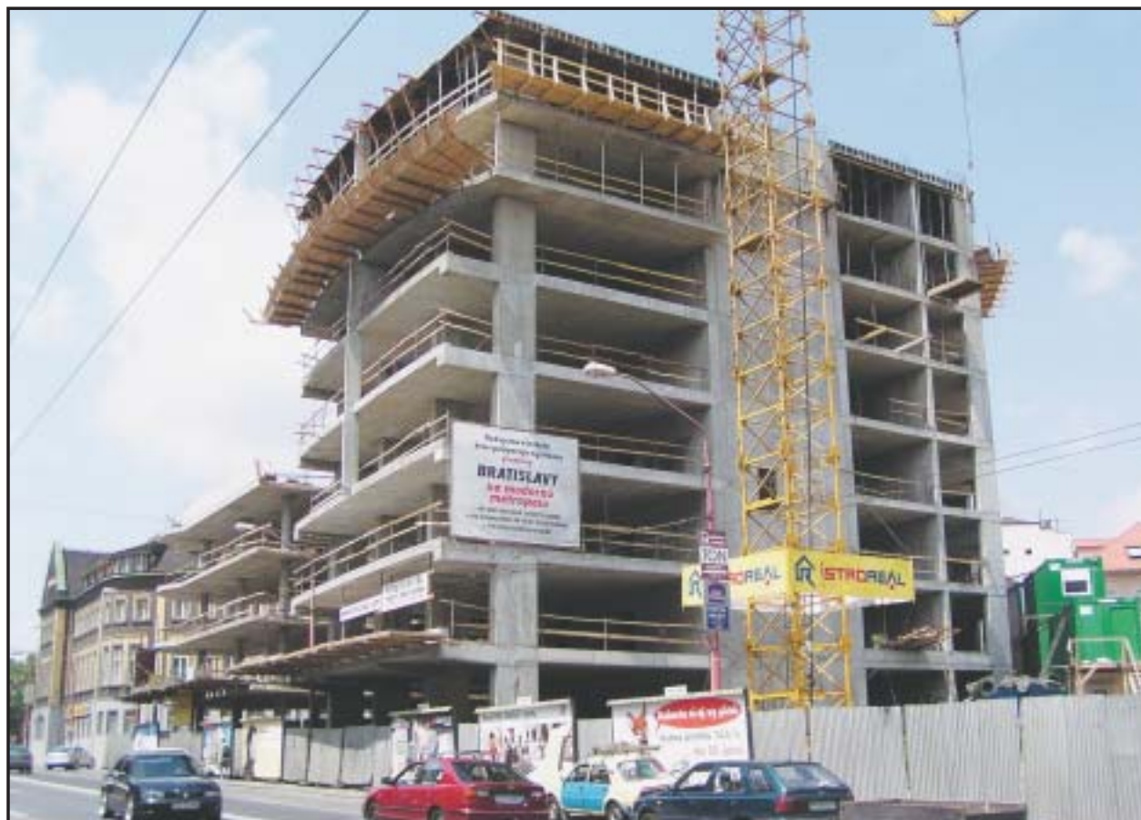
Napriek zamietavému stanovisku ministerstva kultúry ešte stále existuje možnosť, že rozostavaná budova na Šancovej bude mať viac ako osem podlaží, s ktorými ráta platné stavebné povolenie. FOTO - Oto Limpus
