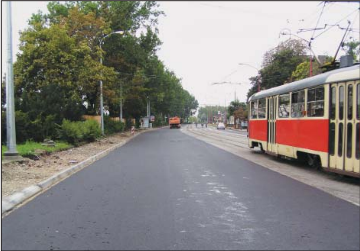
Cesta z Karlovej Vsi do centra mesta je už dvojprúdová aj v úseku od tunela po Nový most, ktoré sa doteraz tvorili zápchy. Vydýchnu si aj obyvatelia Žižkovej ulice, kam bola kvôli stavbe dočasne presmerovaná premávka. FOTO - Oto Limpus
