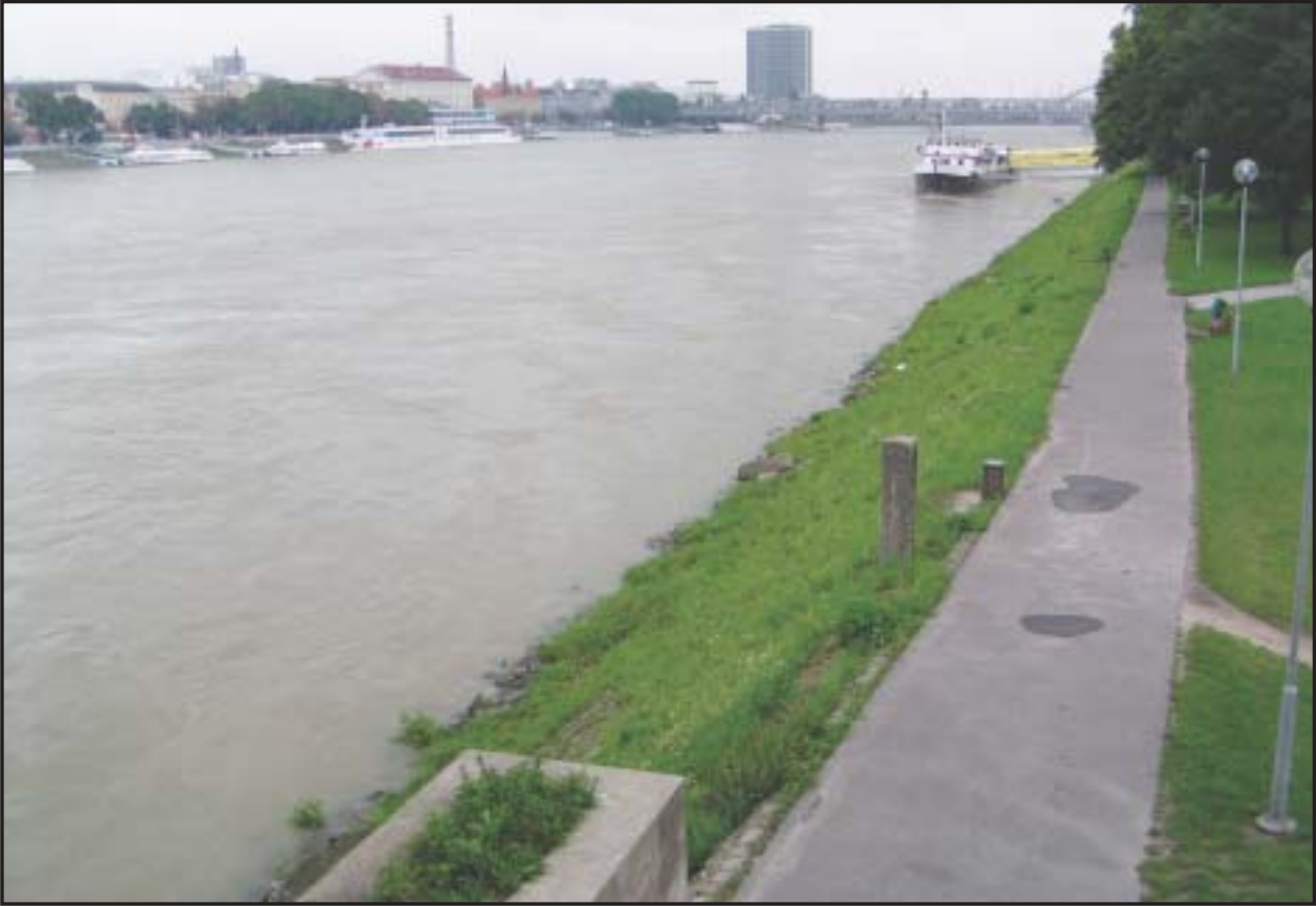
V novembri by sa mal začať stavať nový protipovodňový múr na petržalskom nábreží medzi Novým a Starým mostom, ktorý by mal zvýšiť ochranu pred povodňami. FOTO - Oto Limpus
