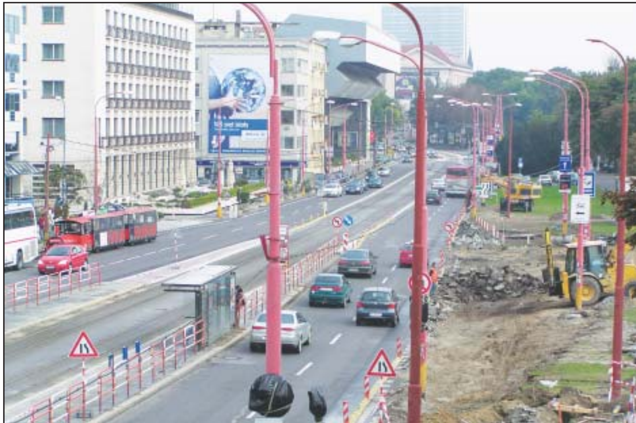
Komunikáciu na nábreží rozširujú, pretože vybudovanie svetelnej signalizácie na križovatke s Rigeleho ulicou si tu vyžaduje zriadenie samostatného odbočovacieho pruhu. FOTO - Oto Limpus
