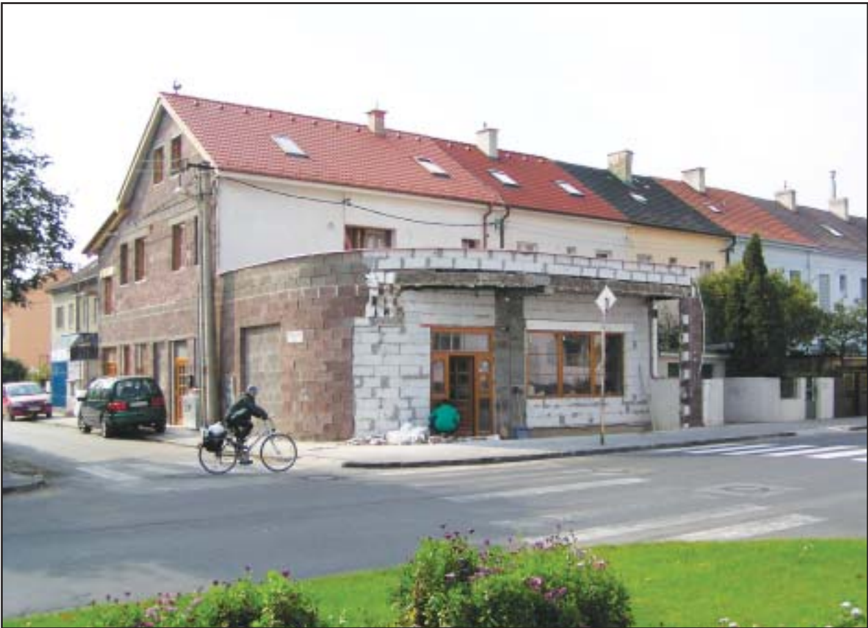
Čiernu stavbu na rohu Riazanskej a Slnecnej ulice stavebník na podnet stavebného úradu odstraňuje. FOTO - Oto Limpus
