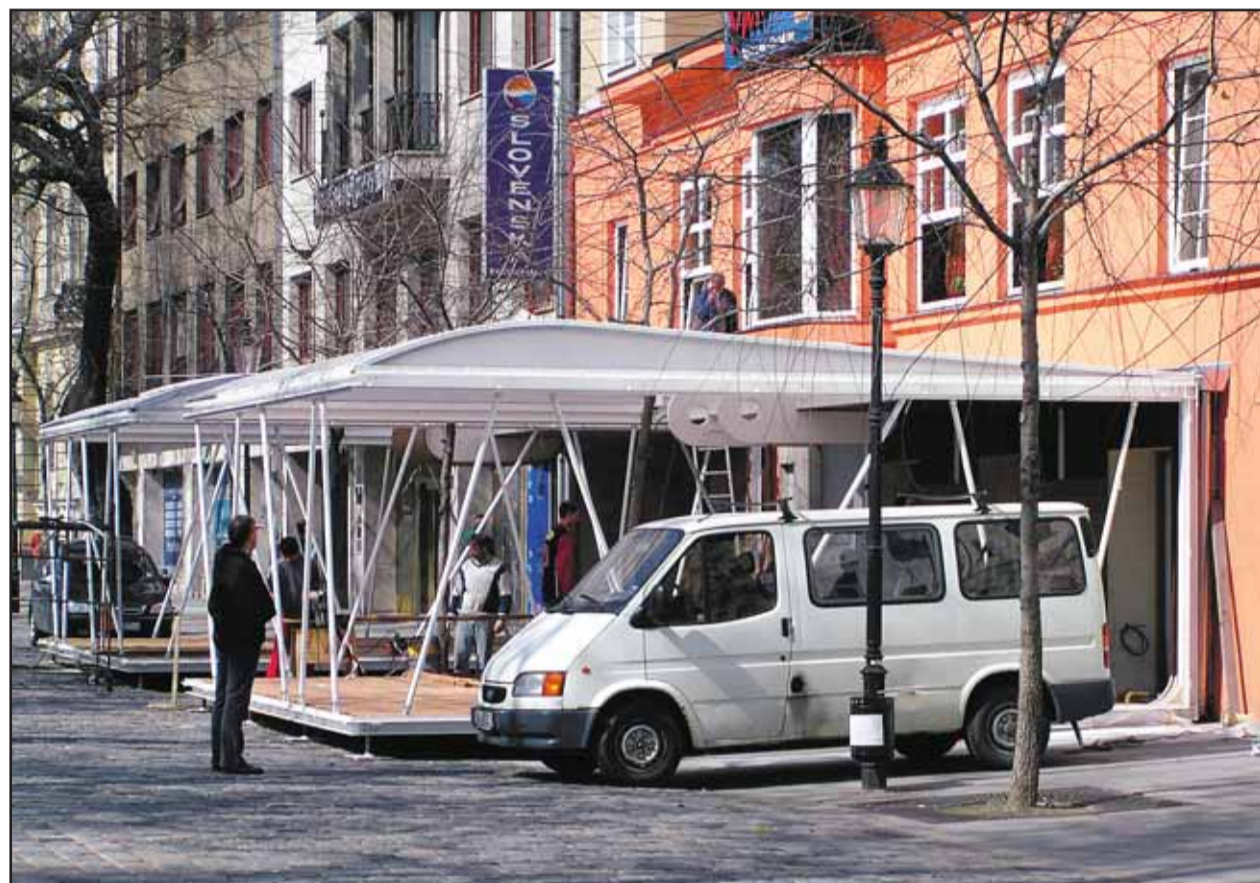
Nová terasa na Hviezdoslavovom námestí podľa všetkého porušuje schválené pravidlá - od fasády domu totiž musí byť pre chodcov zachovaný priechod široký minimálne 125 centimetrov, čo v tomto prípade nie je. FOTO - Oto Limpus
