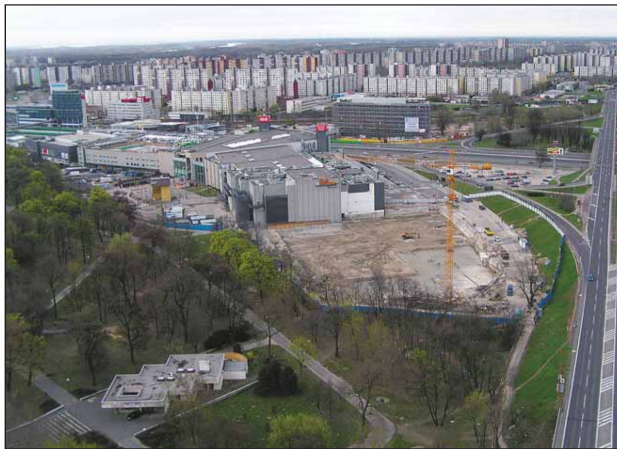
Výstavbu 22-poschodovej veže zatiaľ zastavila spodná voda, o konečnej výške stavby sa vyjednáva. FOTO - Oto Limpus
