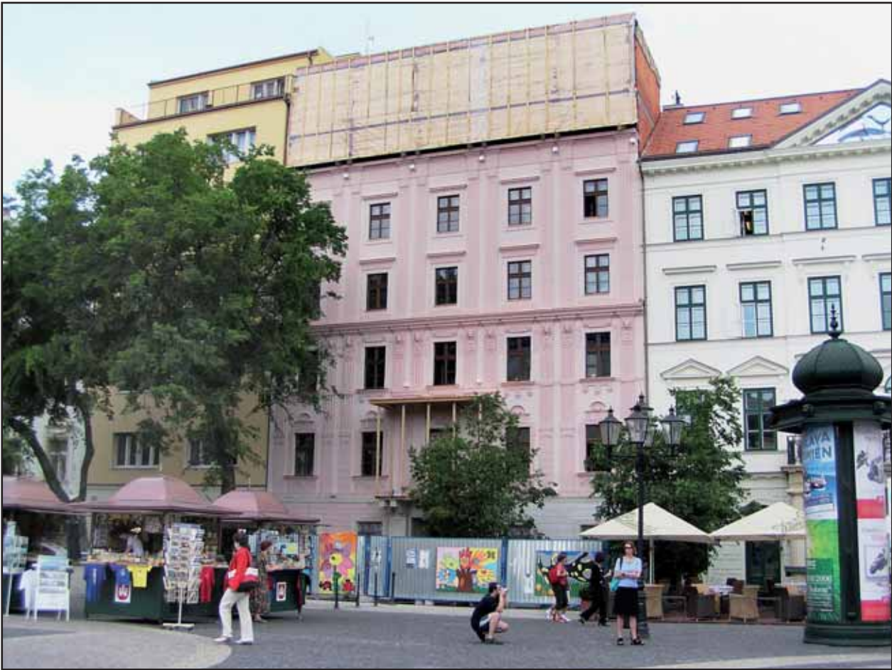
Na pôvodne trojpodlažnom meštianskom dome pamiatkari odobrili ďalšie štyri podlažia.
