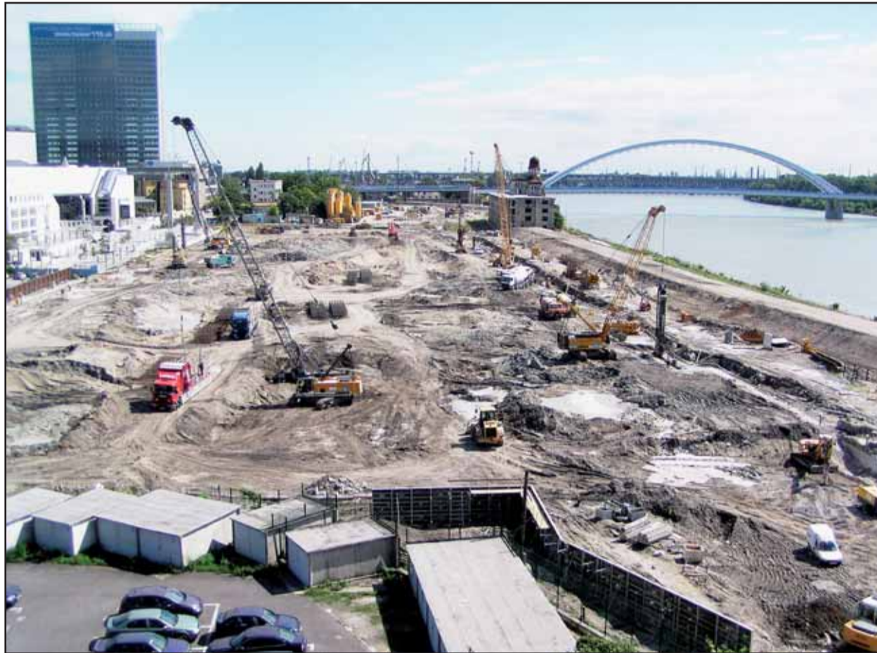
Napriek tomu, že základný kameň novej mestskej štvrte Eurovea bol položený 7. septembra, na stavbe sa intenzívne pracuje už niekoľko týždňov.
