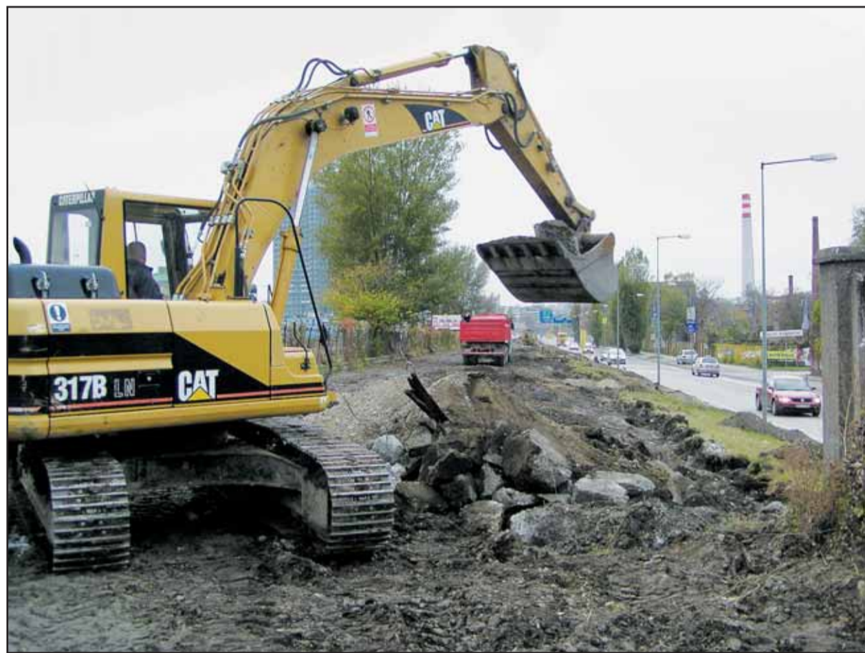
Prekládkou inžinierskych sietí sa začalo rozširovanie Prístavnej ulice.
