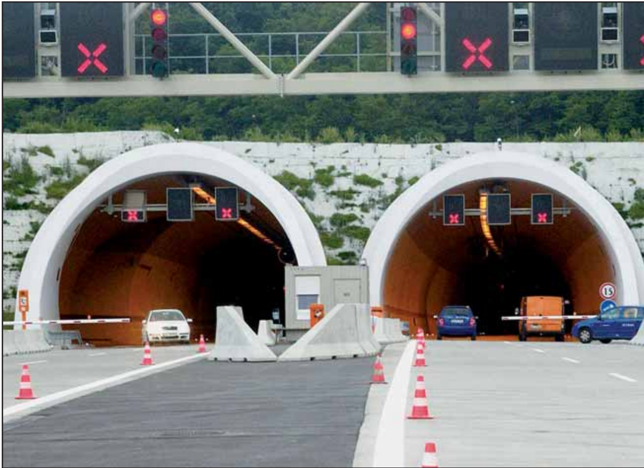
Nový tunel popod Sitinu bude slávnostne otvorený 23. júna, ostrá prevádzka sa začne v pondelok 25. júna. FOTO - TASR
