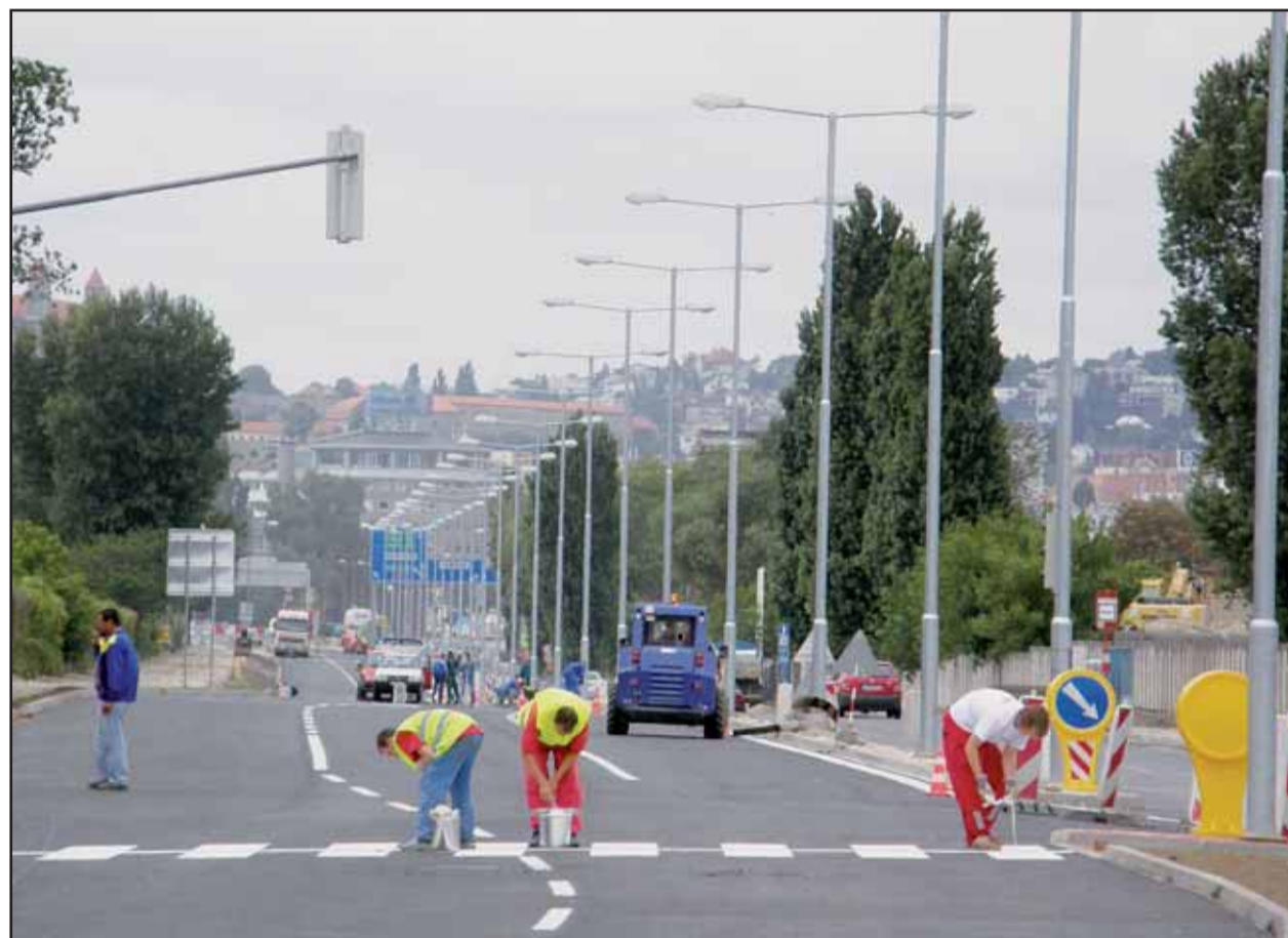
Prístavná ulica by sa mala do konca prázdnin zmeniť na štvorpruhovú komunikáciu.
