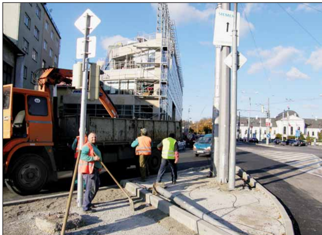
Na križovatke na Suchom mýte v týchto dňoch dokončujú povrchovú úpravu ostrovčekov.
