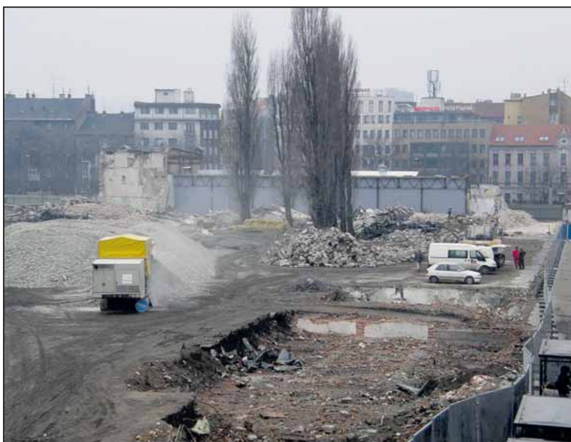
Počas uplynulého víkendy nechal HB Reavis zlikvidovať aj posledné zvyšky Kablovky... FOTO - Oto Limpus
