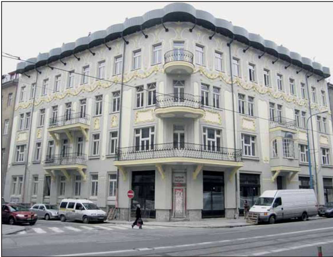
V obnovenom secesnom dome na rohu Tallerovej a Štúrovej ulice bude hotel.
