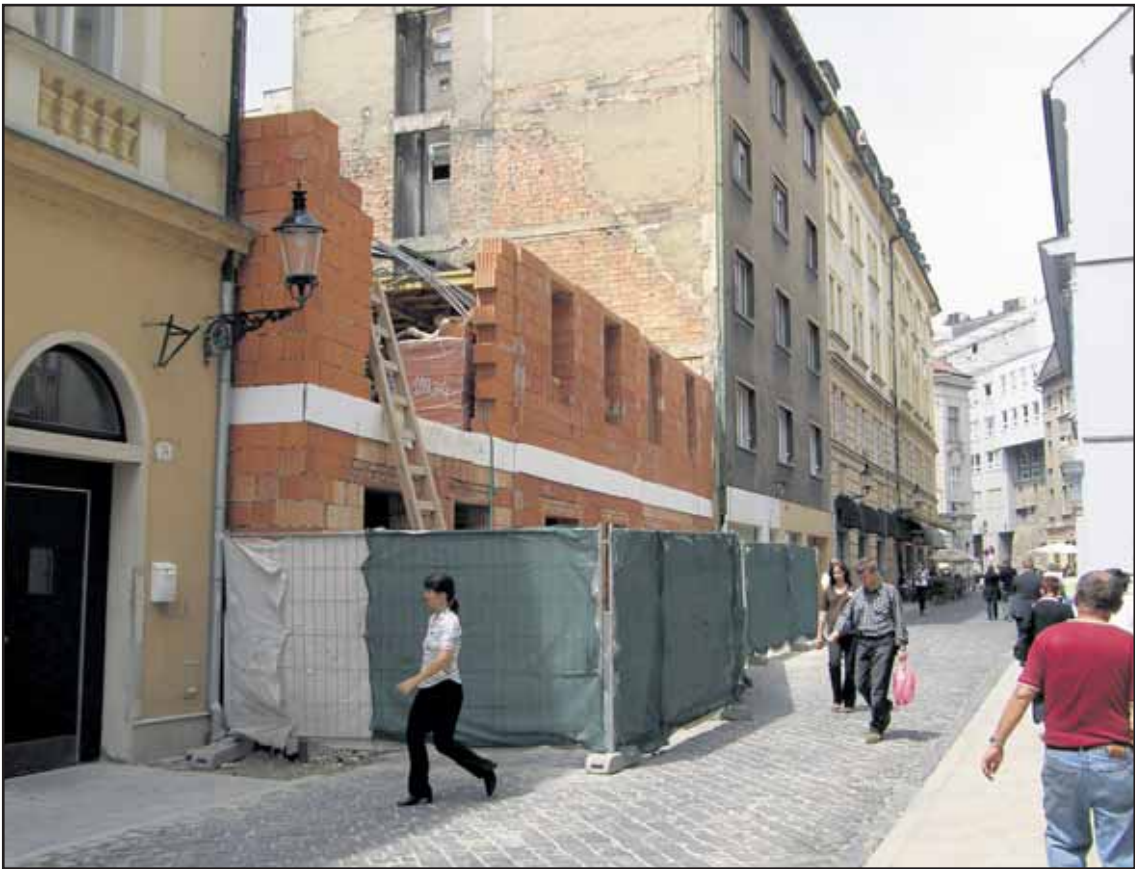
Stavebný úrad ďalšie stavebné práce na Nedbalovej ulici 12 zakázal.
