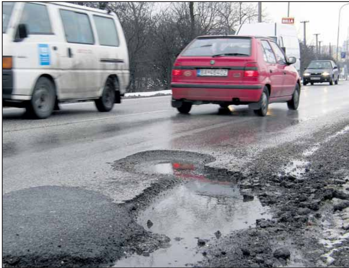
Takýto nebezpečný hlboký výtlk číha na vodičov na Lamačskej ceste.
