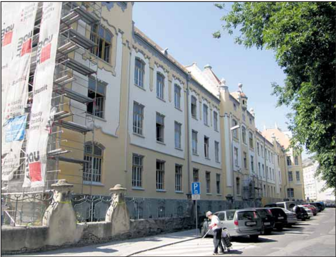
Žltá a biela farba patria k budove gymnázia na Grösslingovej ulici.
