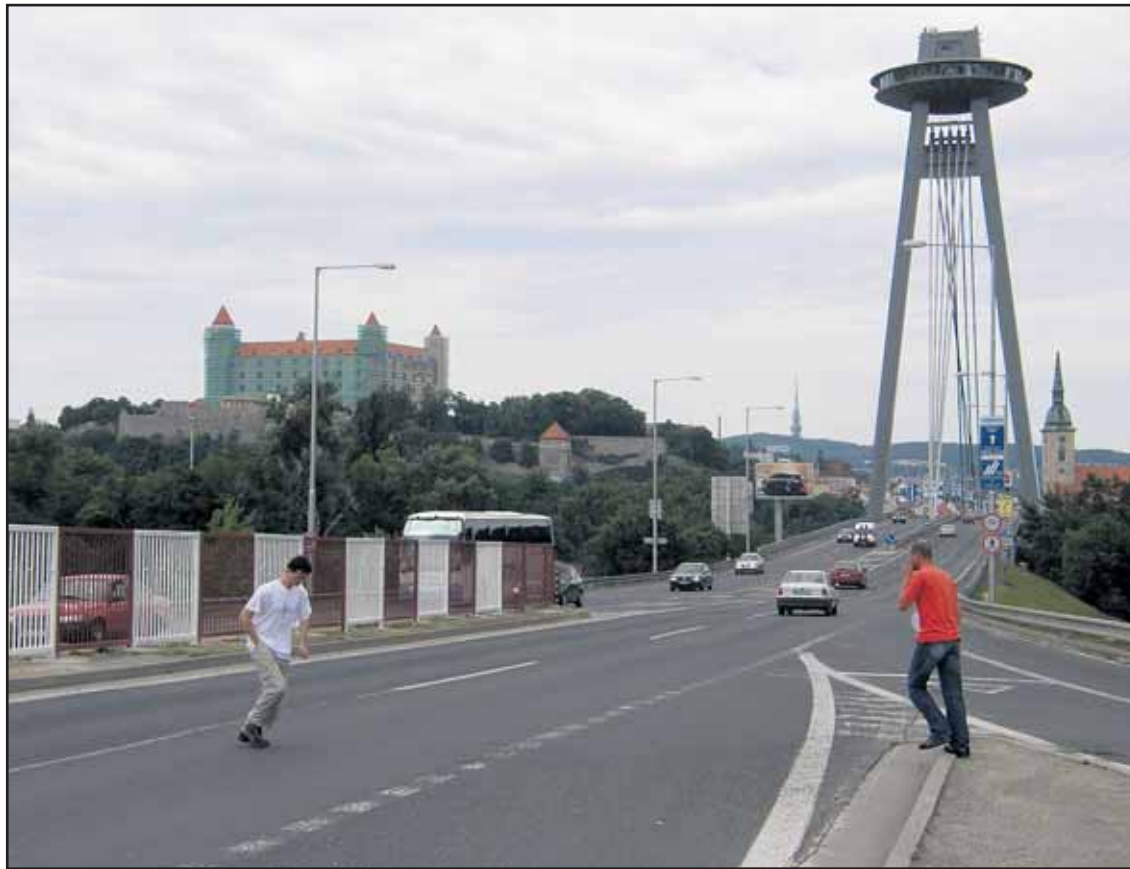
Nebezpečný úsek, ktorý hrozil neustálymi kolíziami, by sa mal stať minulosťou.
