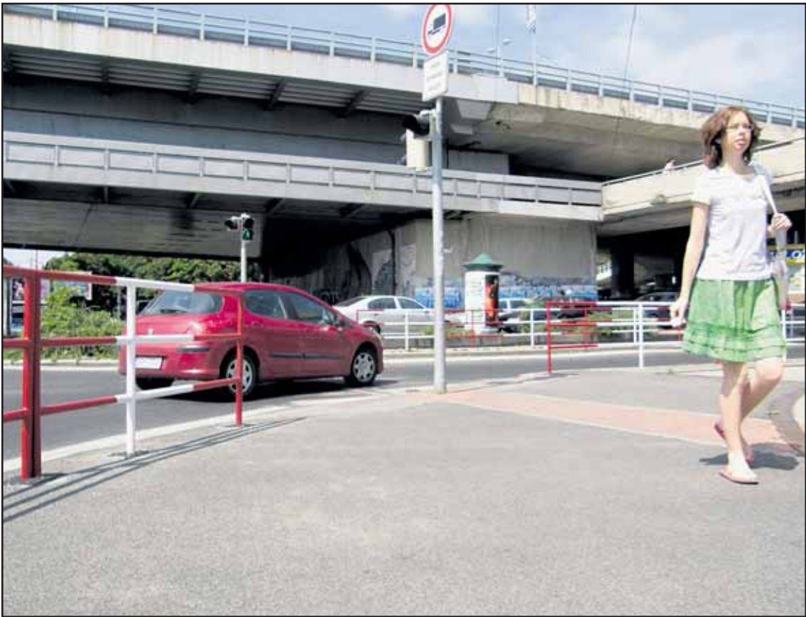
Zábradlie bráni chodcom pri prebiehaní, autá sa však pod Nový most aj tak dostanú.
