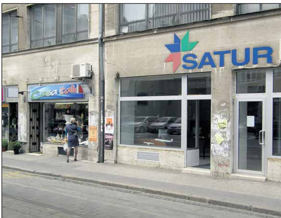
Vchodové dvere a výklad po úprave, v ostatných obchodoch zostal pôvodný stav.
