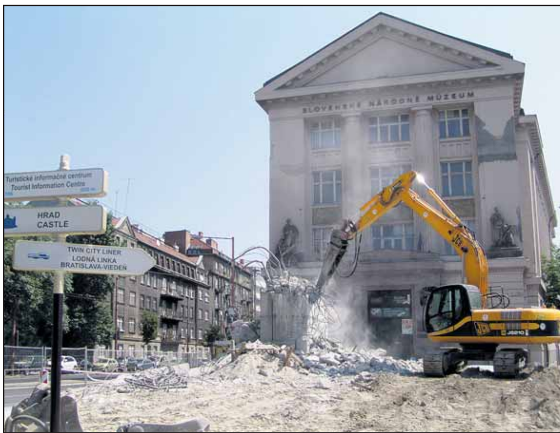
Pylón sa postupne strácal, zostal po ňom len prach a rozbitý betón.
