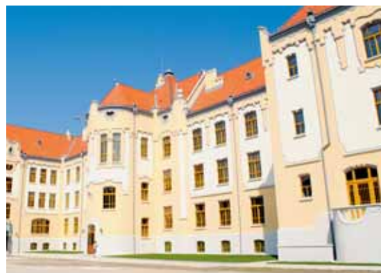
Do zrekonštruovaného Gymnázia na Grösslingovej ulici sa žiaci vrátia 6. septembra 2010.
