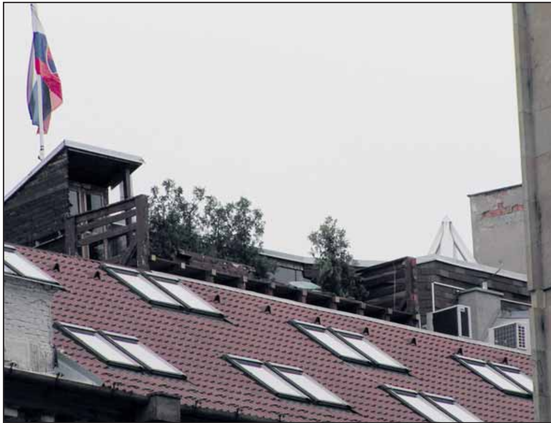
Čiernu stavbu na streche domu by mali čoskoro zbúrať.
