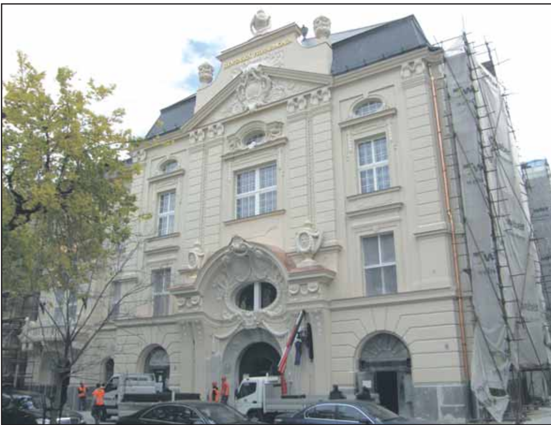
Obnovená fasáda má novú farbu, ktorá je vlastne pôvodná.
