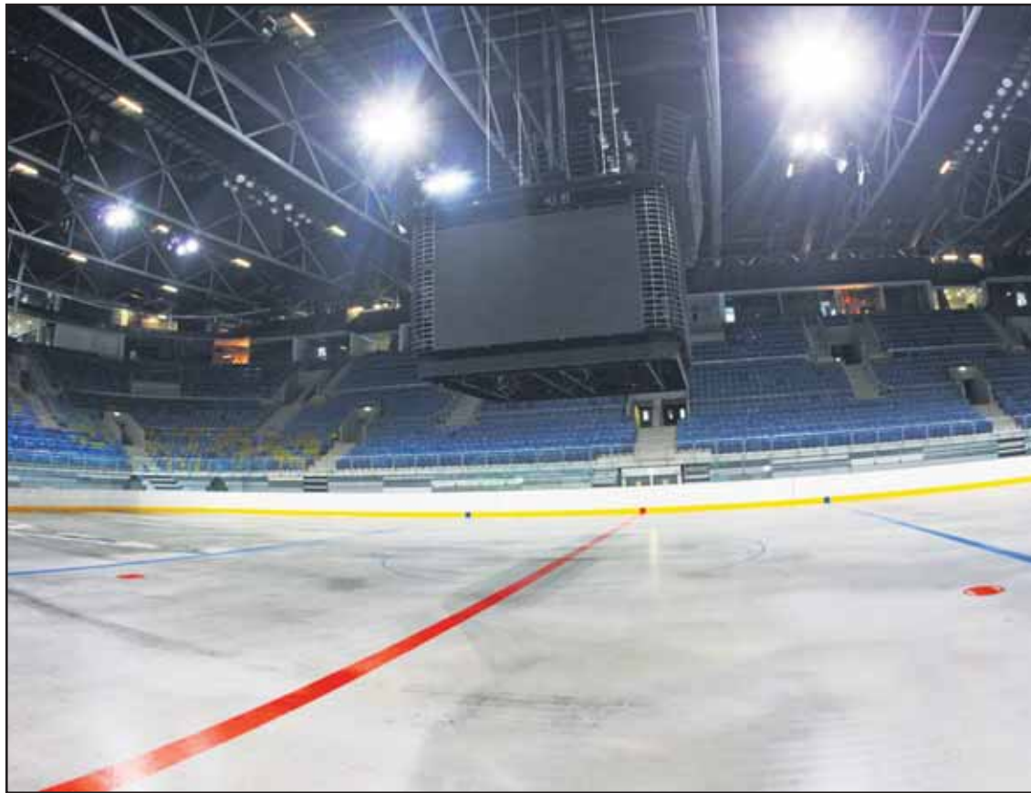
Už budúci týždeň by sa na rekonštruovanom štadióne mal hrať hokej.
