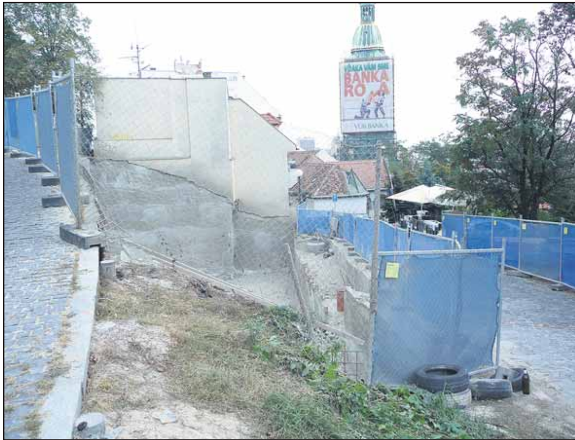
Turisti aj Bratislavčania chodia zatiaľ na Hrad okolo stavebnej jamy.
