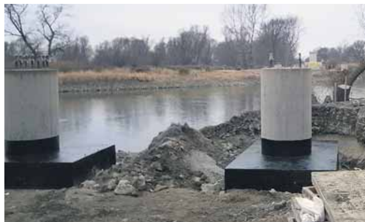
Pilóty budúceho cyklomosta z Devínskej Novej Vsi do Schlosshofu sú už zapustené v zemi.
