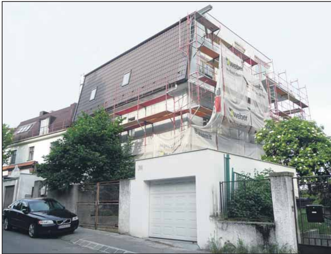
Najnovším prípadom čiernej stavby je nadstavba na Červeňovej ulici 8.
