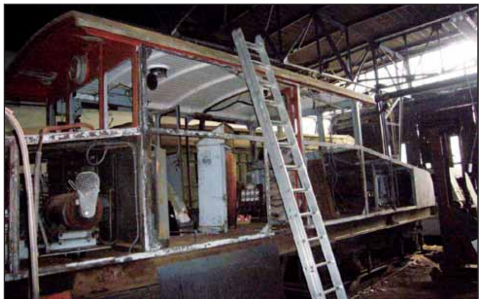
4. Najskôr bolo lokomotívu potrebné rozobrať, odstrániť hrdzu, opraviť všetko, čo sa dalo, poškodené časti nahradiť novými.
